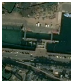
Figure 21 : Vue aérienne de l'écluse Port de Pêche CCI au Tréport (Source : Géoportail)
