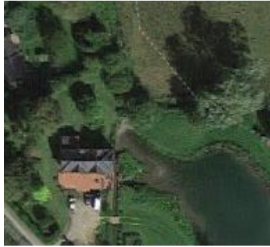
Figure 20 : Vue aérienne du Moulin de Godets (Source : Géoportail)
