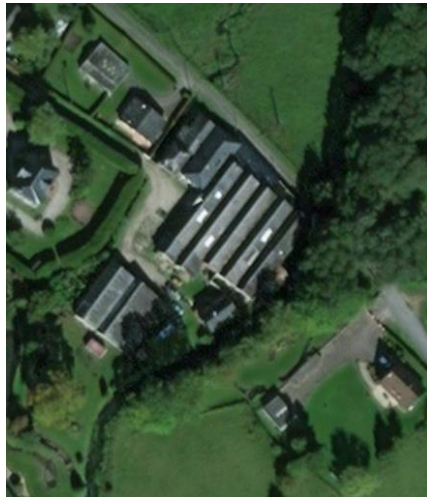
Figure 21 : Vue aérienne de la microcentrale de la Chaussée (Source : Géoportail)
