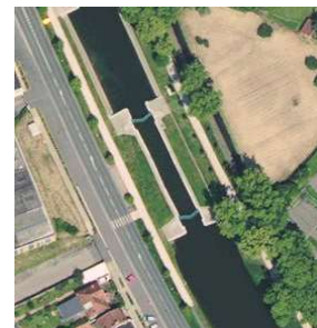
Vue aérienne de l'écluse d'Abbeville
