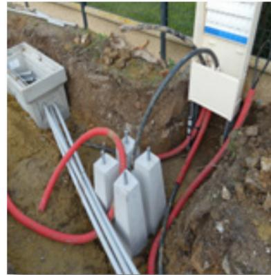
Dans toutes les tranchées ouvertes pour les réseaux électriques, la Fédération étudie et subventionne la pose de fourreaux et de chambres de communications électroniques. Ces ouvrages constituent une infrastructure de communications électroniques plus couramment appelée « Génie Civil ».
