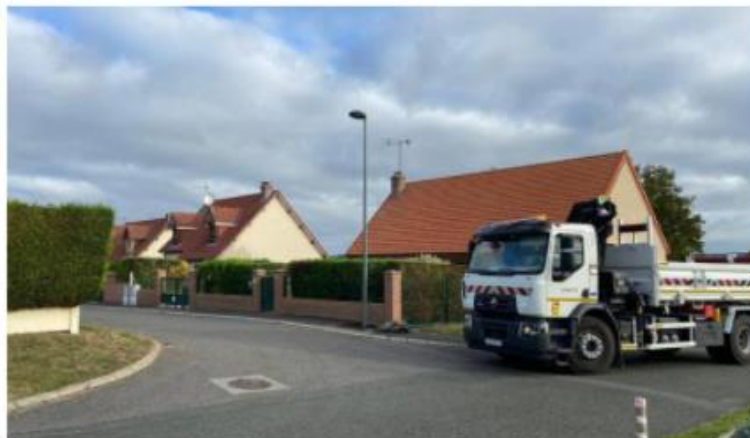
Le chantier s'achève. Les rues seront désormais mieux éclairées et à moindre coût.
