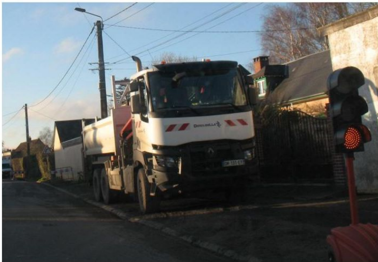
Les travaux sont prévus jusqu'au printemps.
