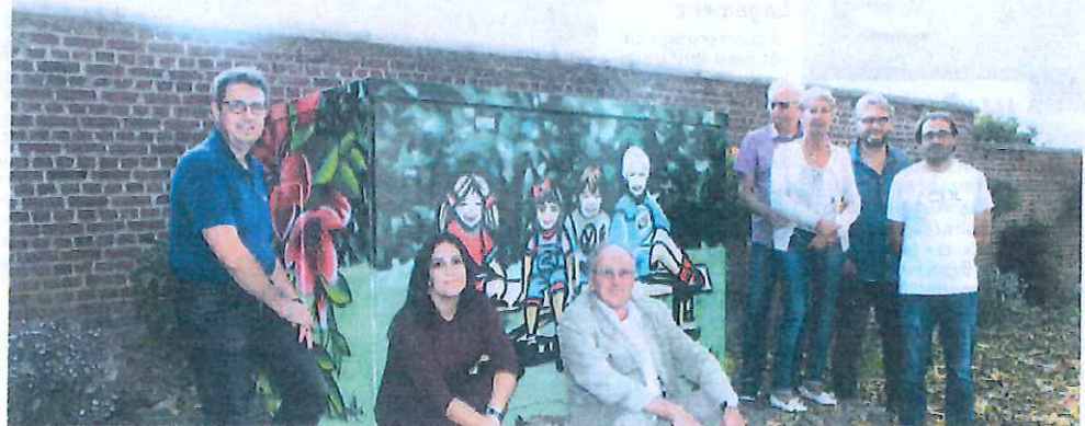
L'inauguration a eu lieu en présence de Fanny Boimare (à la 2 e place en partant de la gauche), qui a coloré le transformateur.
