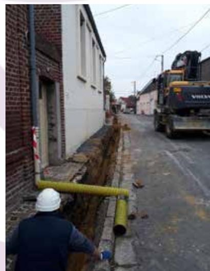
Construction d'un réseau public de distribution de gaz propane de 1 202 ml pour 4 raccords.
