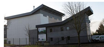
Chaufferie bois du réseau de chaleur d'Abbeville 3
