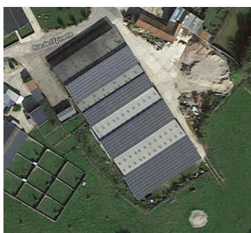
Toiture PV agricole à Bellancourt 2
