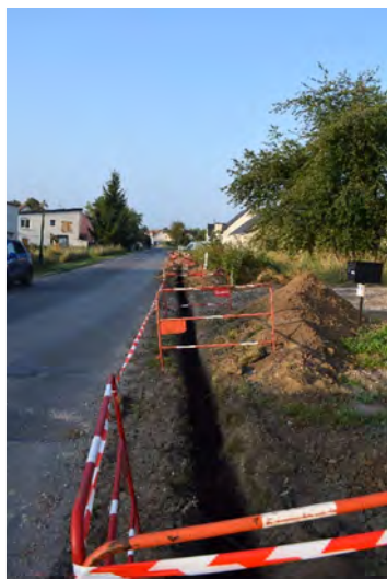
PROUZEL raccordement d'une habitation
