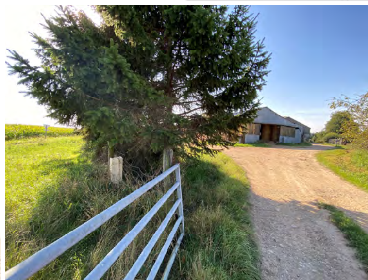
CAMPS EN AMIENOIS Raccordement d'un bâtiment agricole
