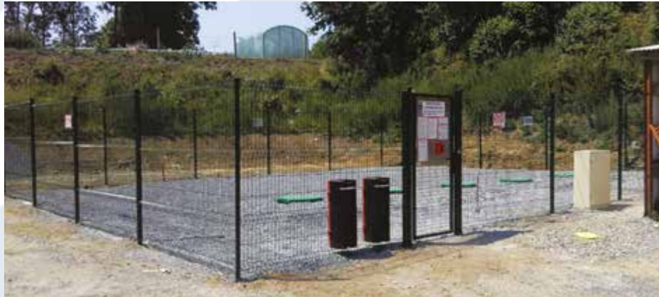
Construction d'un réseau public de distribution de gaz propane de 1 535 ml pour 25 raccords.
