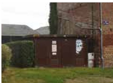
CONTY / Renforcement du réseau Avant
