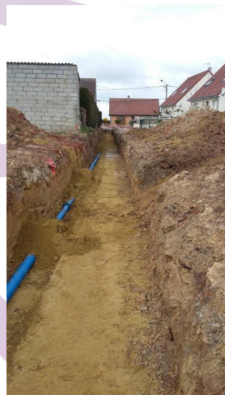
Aménagement du terrain de stockage.
