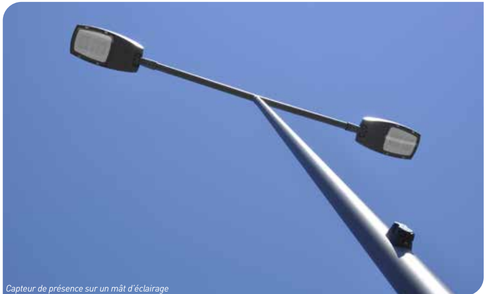
Capteur de présence sur un mât d'éclairage
