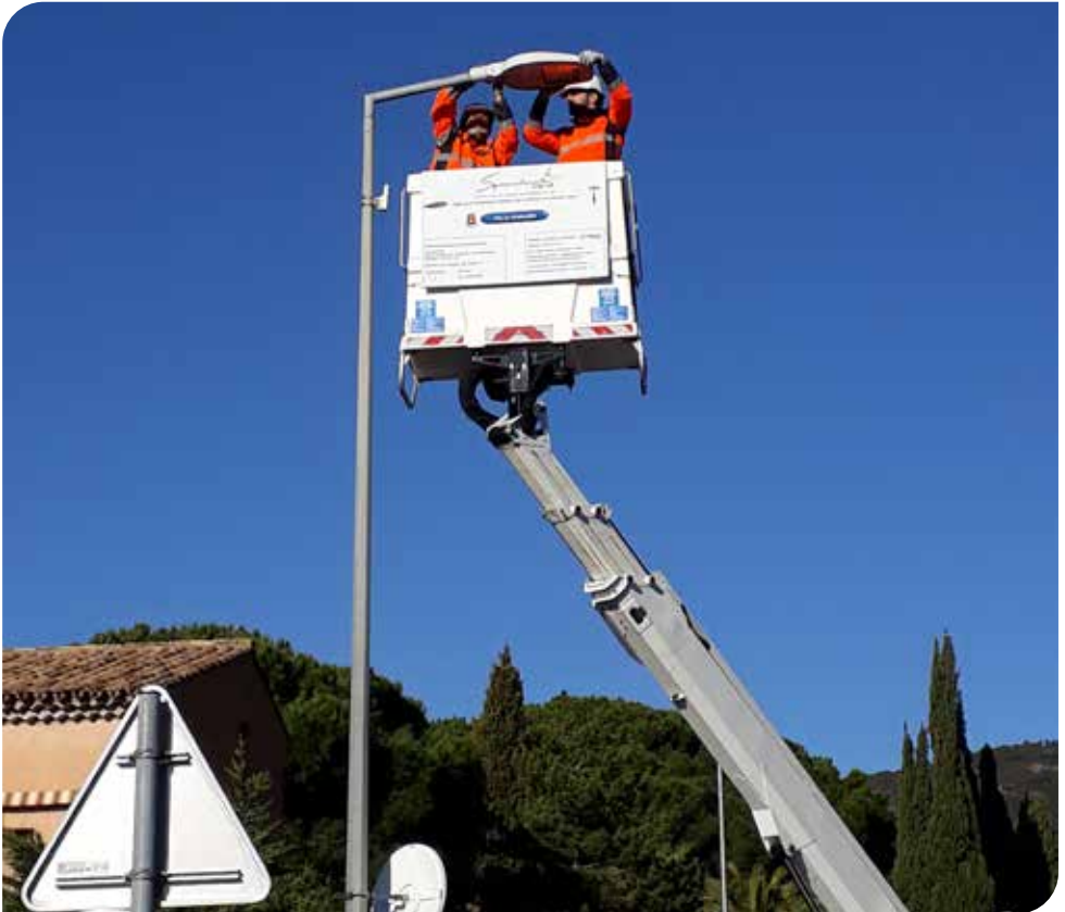
Travaux de maintenance du réseau d'éclairage public du SymielecVar
