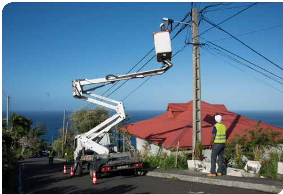
Travaux de maintenance réalisés par le SyMEG - Territoire d'énergie Guadeloupe
