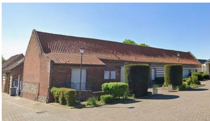
Rénovation thermique de la Mairie et de l'Ecole de PONT NOYELLES et mise en place d'une Pompe à Chaleur Air/Air
