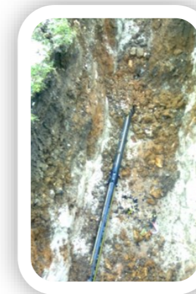
Travaux réalisés dans la commune de REVELLES
