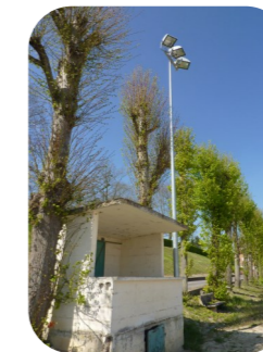
Eclairage Pétanque de Bray/Somme
