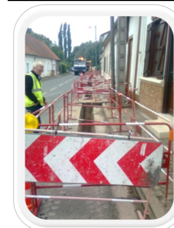
Travaux réalisés à Quesnoy sur Araines
