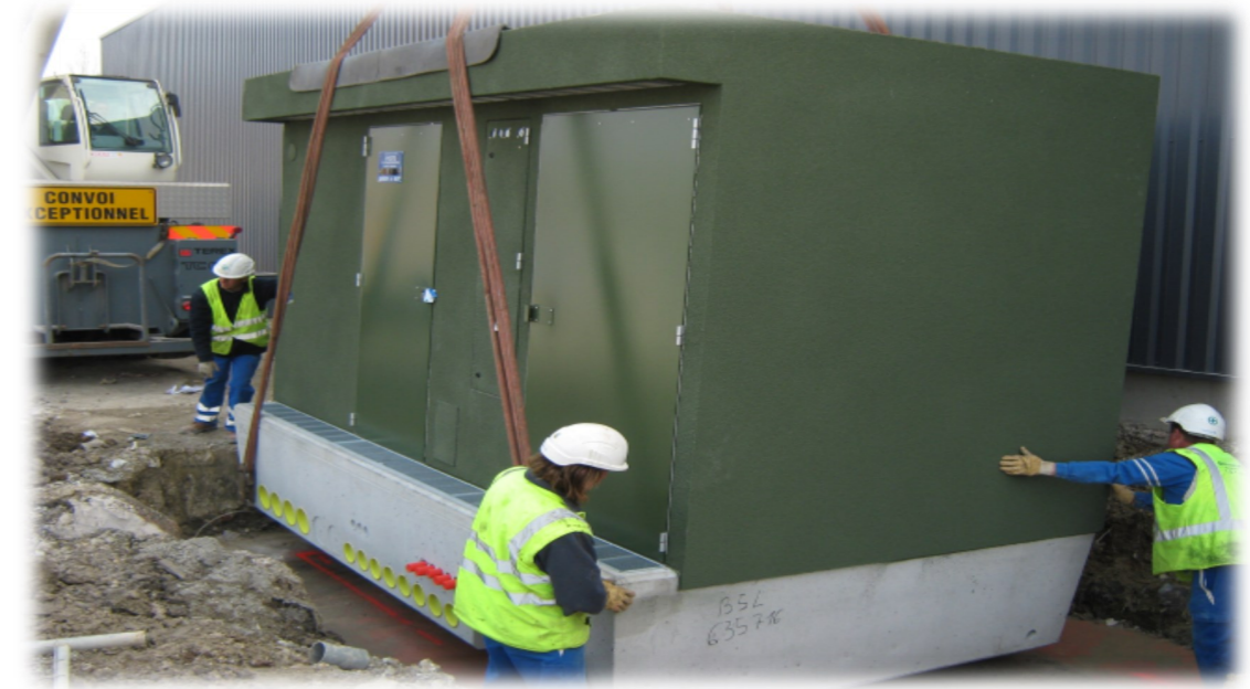
Mise en place d'un poste de transformation.
